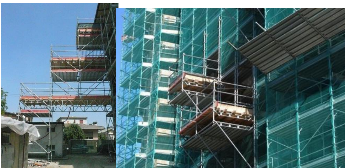
Figura 3-1 | Esempio di mensole di carico materiali e di piano di carico.
