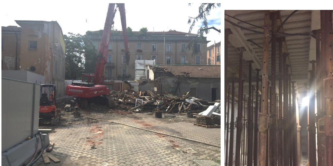
Figura 2-4 | Esempio di escavatore con pinza demolitrice e di puntellatura di forza.
